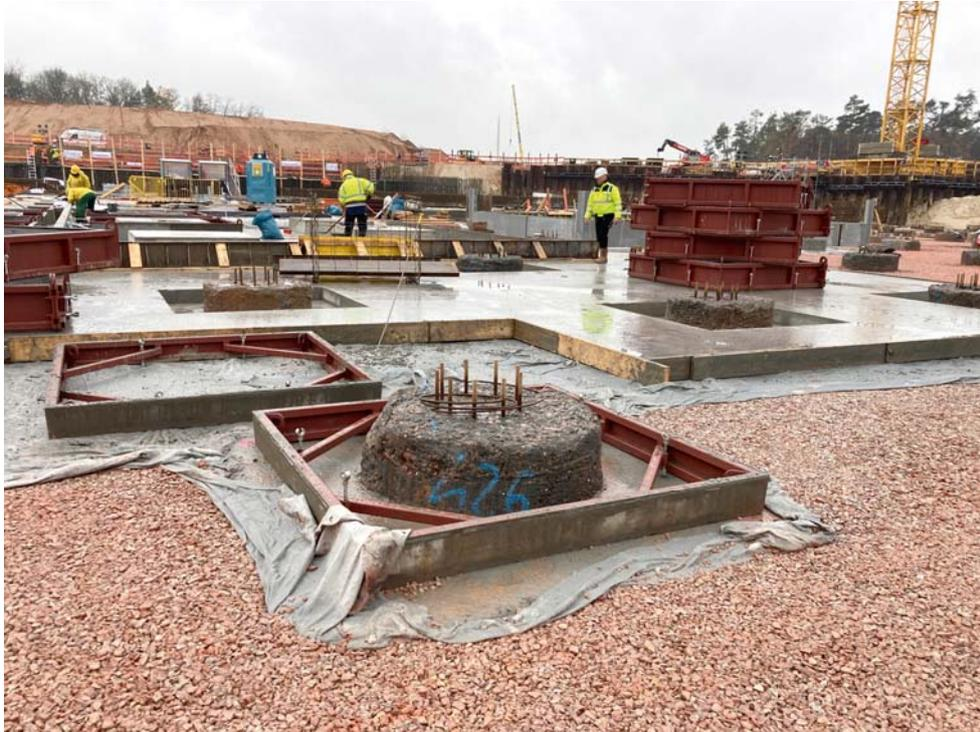
*BU: Vorne: Konisch geformte Schalung für einfaches Ausschalen.
