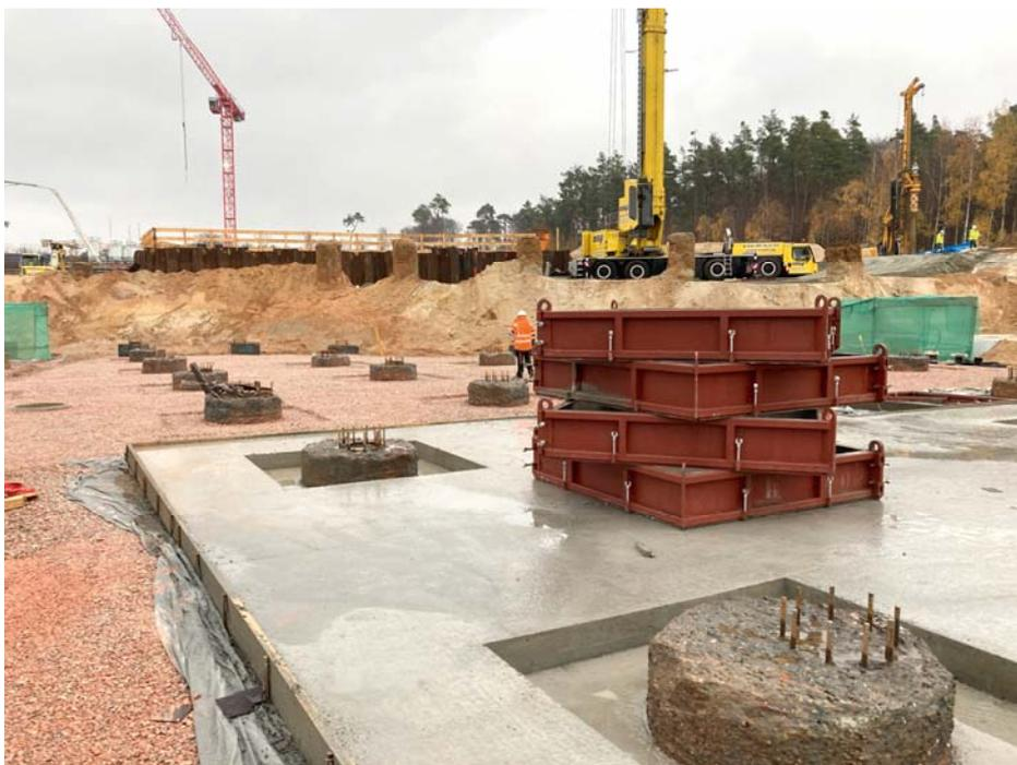
*BU: Schalungen für den zweiten Betonageschritt liegen bereit.
