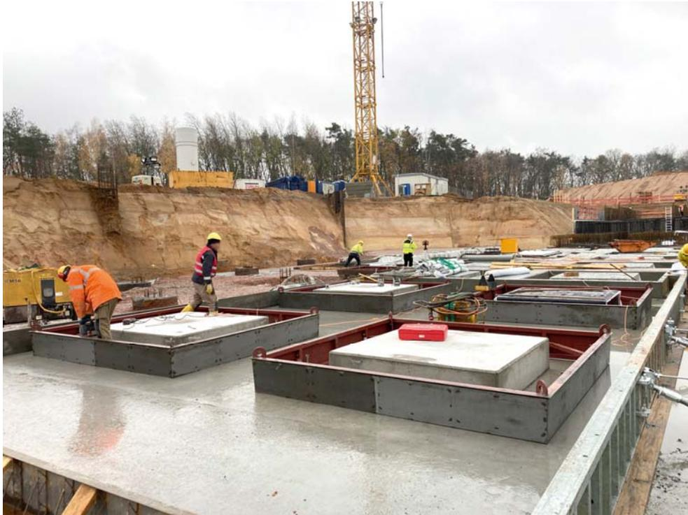
*BU: Montage der Schalungen für den dritten Betonageschritt.
